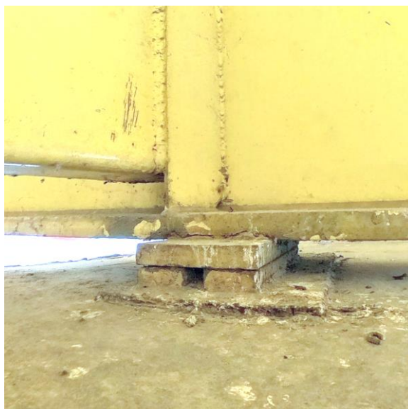
Fotografia istniejącego łożyska wahaczowego na podporze F2:
