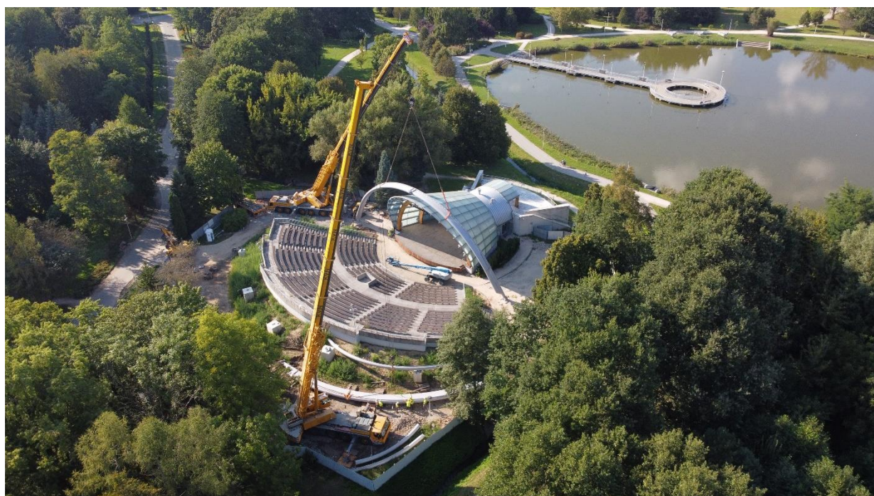
Budowa zadaszania amfiteatru z lotu ptaka.
