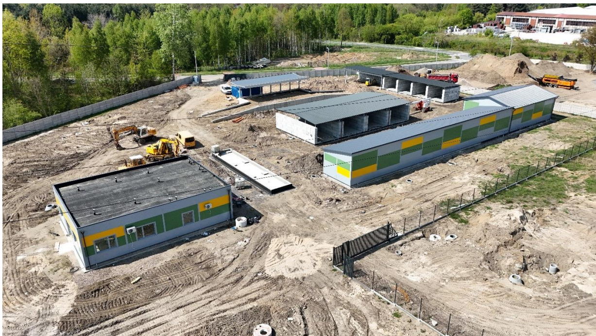
Punkt Selektywnej Zbiórki Odpadów Komunalnych w trakcie budowy.
