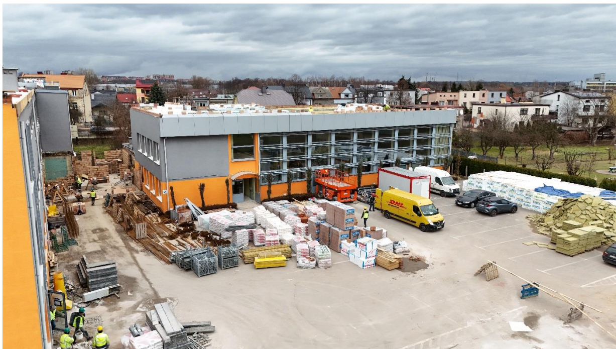
Ostrowiecki Integrator Edukacji i Przedsiębiorczych w budowie.
