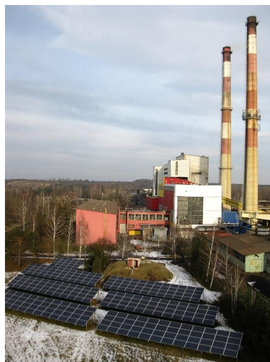
Fotovoltaika Miejskiej Energetyki Ciepłej
