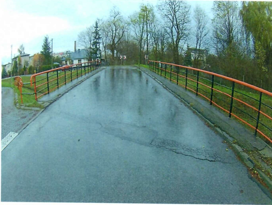
Fot. 1. Widok ogólny na most oraz na nawierzchnię jezdni
