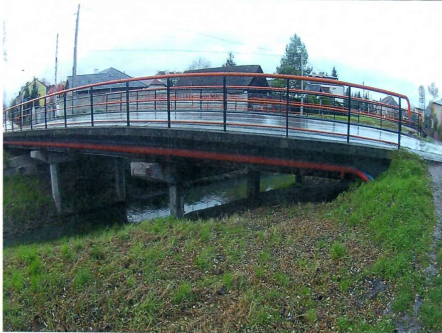
Fot. 3. Widok boczny na obiekt
