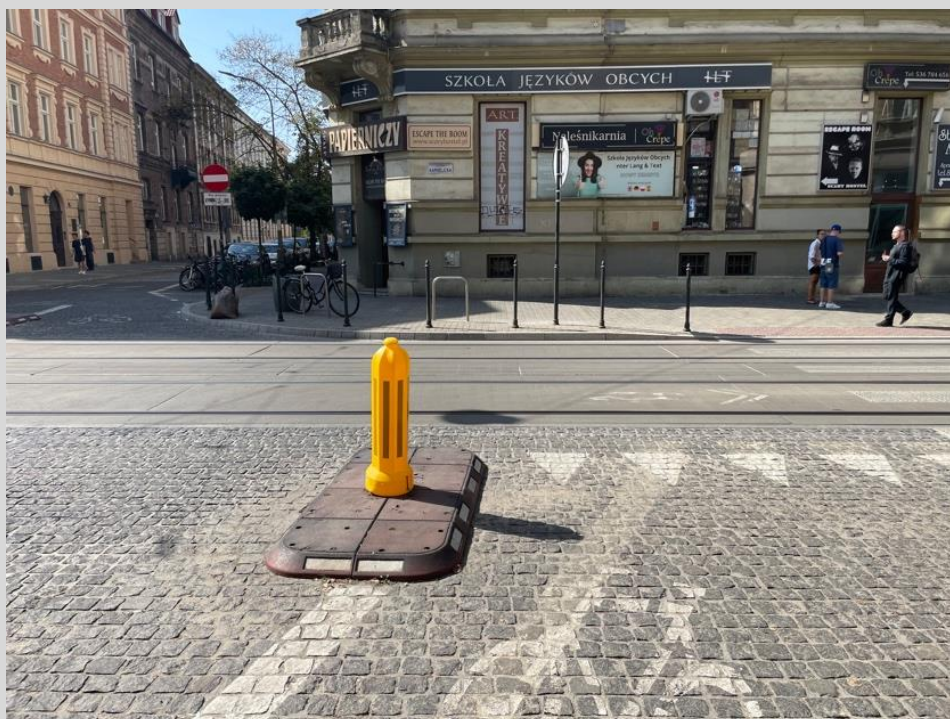
Fotografia 3. Wyspa separacyjna na wlocie ulicy z kontraruchem
