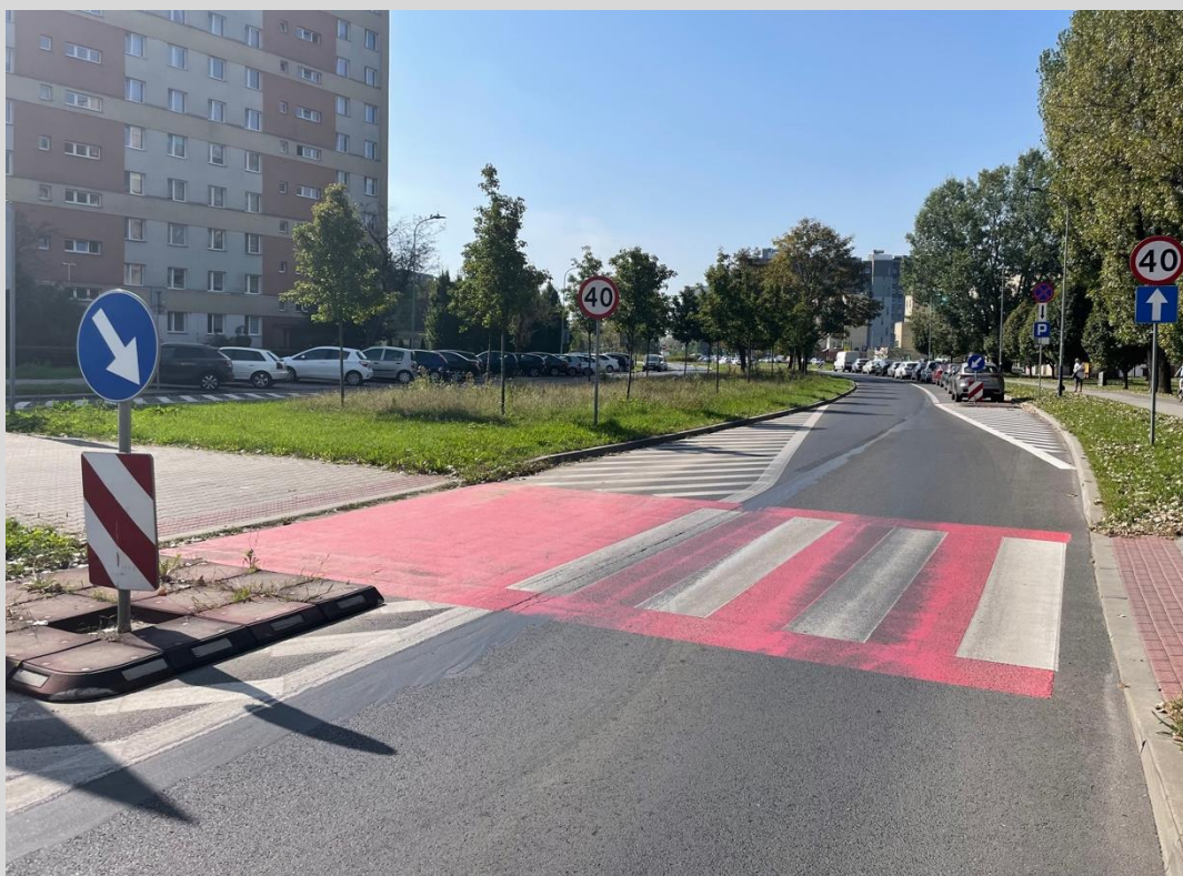
Fotografia 16. Przykład wymuszania zmiany toru jazdy samochodów
