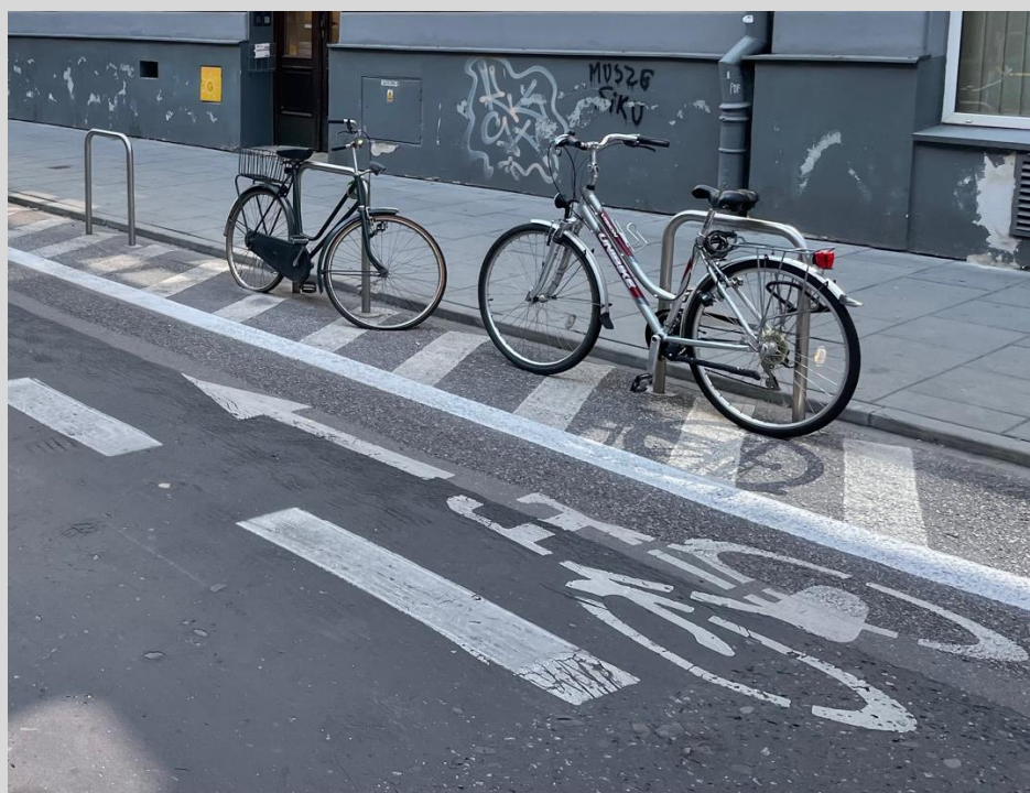
Fotografia 4. Wydzielony pas rowerowy na jezdni
