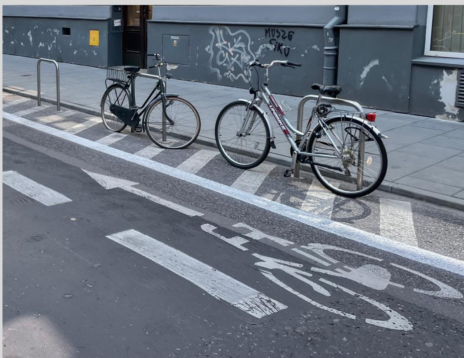
Fotografia 4. Wydzielony pas rowerowy na jezdni
