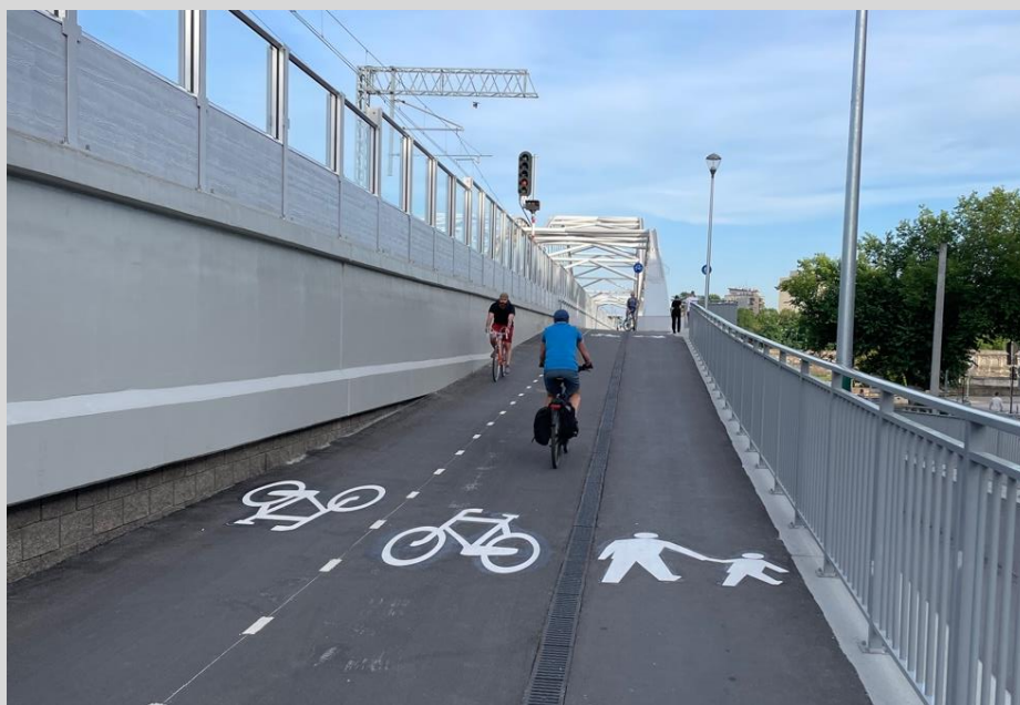
Fotografia 8. Ciąg pieszo-rowerowy z separacją ruchu pieszego i rowerowego
