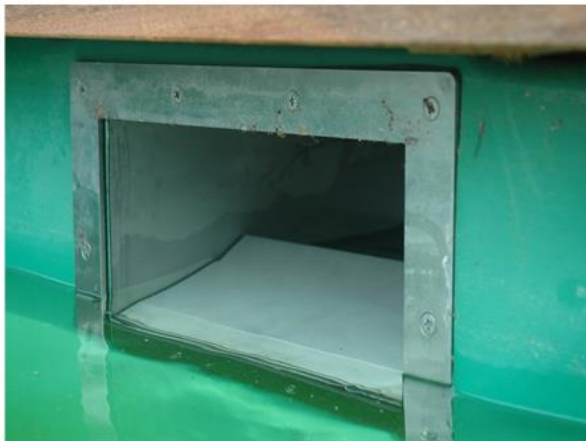
Wlot skimmera ściennego z klapką.
