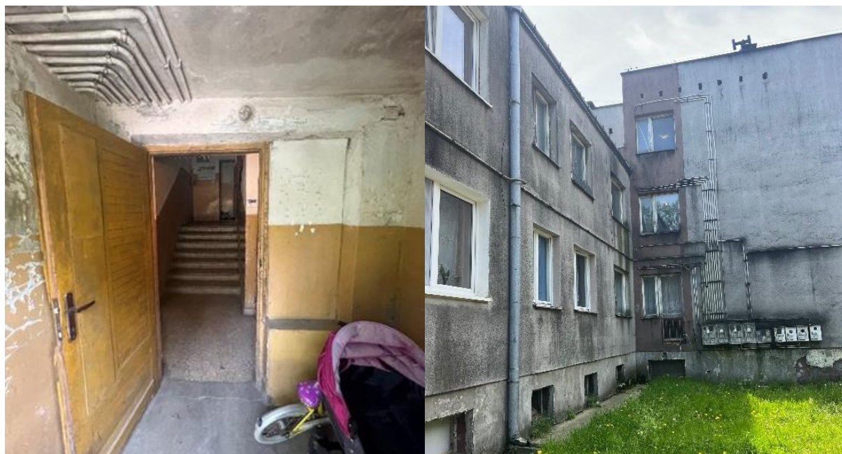
Rysunek 25. Na zdjęciu po lewej i po prawej: Niezadawalający stan techniczny budynków socjalnych przy ul. J. Samsonowicza.
