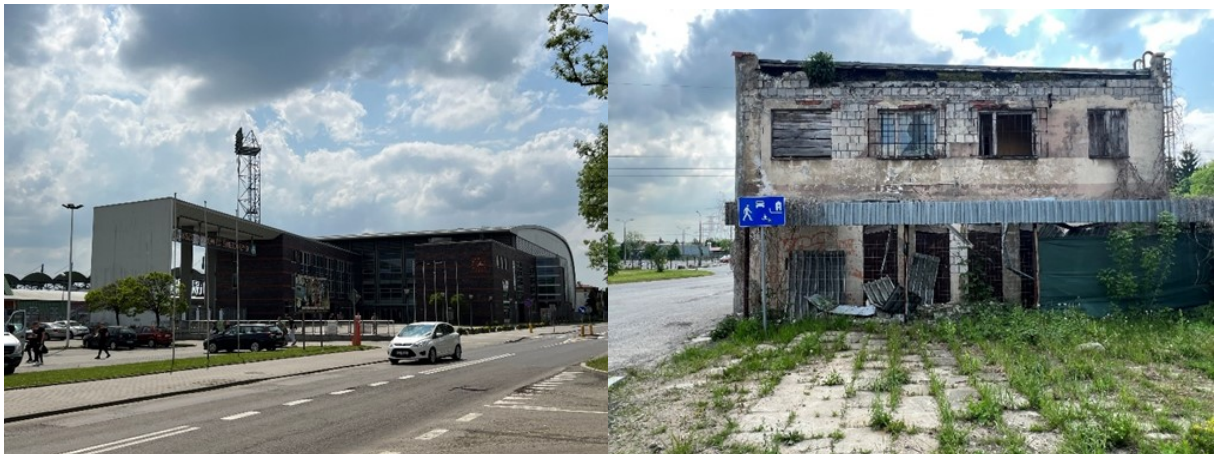
Rysunek 21. Na zdjęciu po lewej: Stadion Miejski MOSiR - główny obiekt sportowo-rekreacyjny w Podobszarze. Na zdjęciu po prawej: Zdegradowana część terenów dawnej Huty Ostrowiec - ulica Kwiatkowskiego
