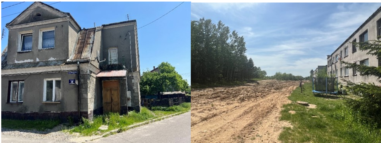
Rysunek 25. Na zdjęciu po lewej: Niska jakość zabudowy komunalnej w centrum Denkowa – ulica Browarna. Na zdjęciu po prawej: Przebudowa układu drogowego w sąsiedztwie budynków socjalnych przy ul. Samsonowicza
