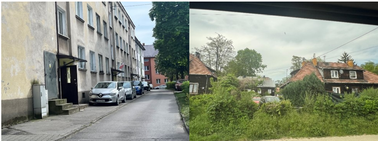
Rysunek 15. Na zdjęciu po lewej: Zawłaszczanie przestrzeni wspólnej, wewnątrzsiedlowej pod potrzeby parkingowe. Na zdjęciu po prawej: Niezadawalający stan budynków komunalnych – tzw. „fińskich domków” przy ul. Kuźnia
