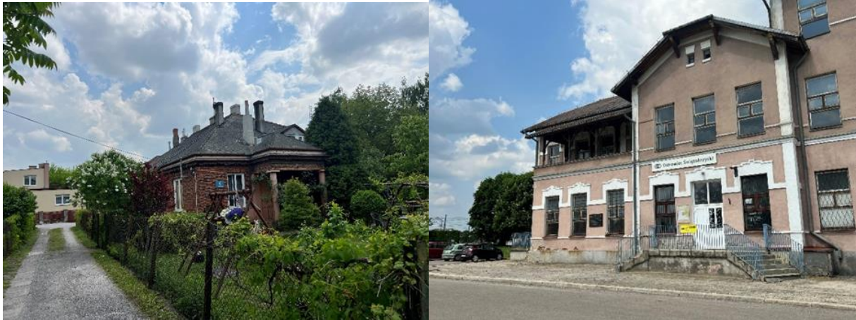
Rysunek 20. Na zdjęciu po lewej: Niezadawalający stan zabytkowych budynków przy ul. Moniuszki – m.in. azbestowe pokrycie dachowe. Na zdjęciu po prawej: Dworzec PKP w Ostrowcu Świętokrzyskim – zły stan techniczny, budynek wyłączony z użytkowania
