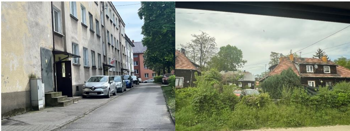
Rysunek 15. Na zdjęciu po lewej: Zawłaszczanie przestrzeni wspólnej, wewnątrzsiedlowej pod potrzeby parkingowe. Na zdjęciu po prawej: Niezadawalający stan budynków komunalnych – tzw. „fińskich domków” przy ul. Kuźnia
