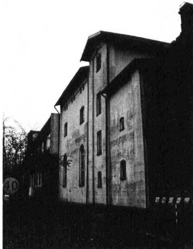
Fot. 1 Budynek dawnego browaru. Widok elewacji od strony ulicy Polnej. Otynkowane elewacje segmentu A i B który poddany został pracom remontowym z zabezpieczeniem elementów i układów konstrukcyjnych.
