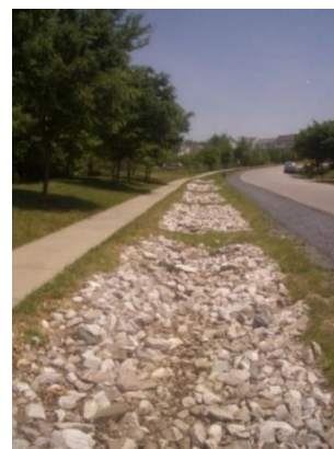
Ryc. 3 Drenaż francuski, źródła (od lewej): https://harborgreenscapes.com/drainage/french-drain/ ; https://sustainablestormwater.org/2007/05/23/infiltration-trenches/
