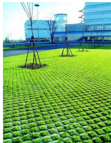
Ryc. 1 Przykłady wprowadzania powierzchni przepuszczalnych; źródła (od lewej): https://pol-trade.com.pl/151/ekoway-2 ; http://polbruksklep.pl/plyta-azurowa-meba-gr-8cm.html
