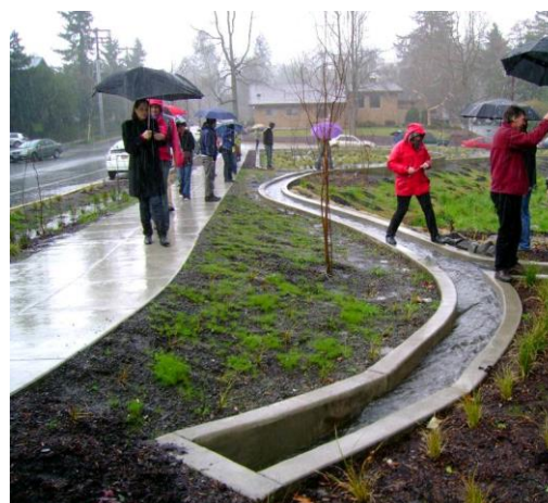
Ryc. 2 Przykłady wprowadzania korytek spływowych w przestrzeń miejską, źródła (od lewej): Handbook on sustainable urban drainage systems, (D)rain for Life, Estonia-Latvia Programme; https://waynecountynysoilandwater.org/wp-content/uploads/2013/12/landscape-arch.jpg
