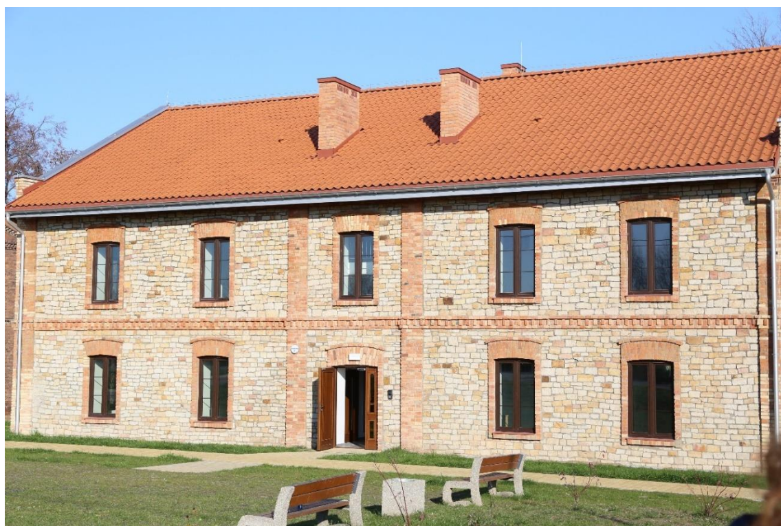
Budynek socjalny przy ul. Osadowej 6. Fot. archiwum UM.
