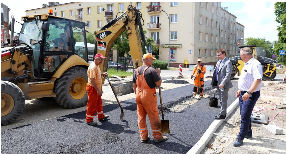
Prace remontowe przy ulicy Szerokiej. Fot. archiwum UM.
