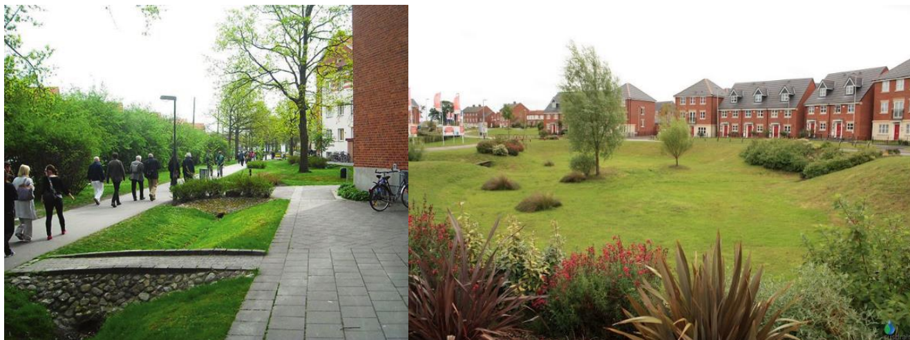
Ryc. 4 Zagłębienia infiltracyjne, źródła (od lewej): https://www.researchgate.net/figure/Drainage-system-Augustenberg-Malmoe-Sweden_fig6_251179698 ; https://developersguide.njfuture.org/what-is-green-infrastructure/large-landscape-practices/infiltration-basin/
