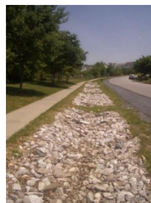
Ryc. 3 Drenaż francuski, źródła (od lewej): https://harborengreescapes.com/drainage/french-drain/ ; https://sustainablestormwater.org/2007/05/23/infiltration-trenches/
