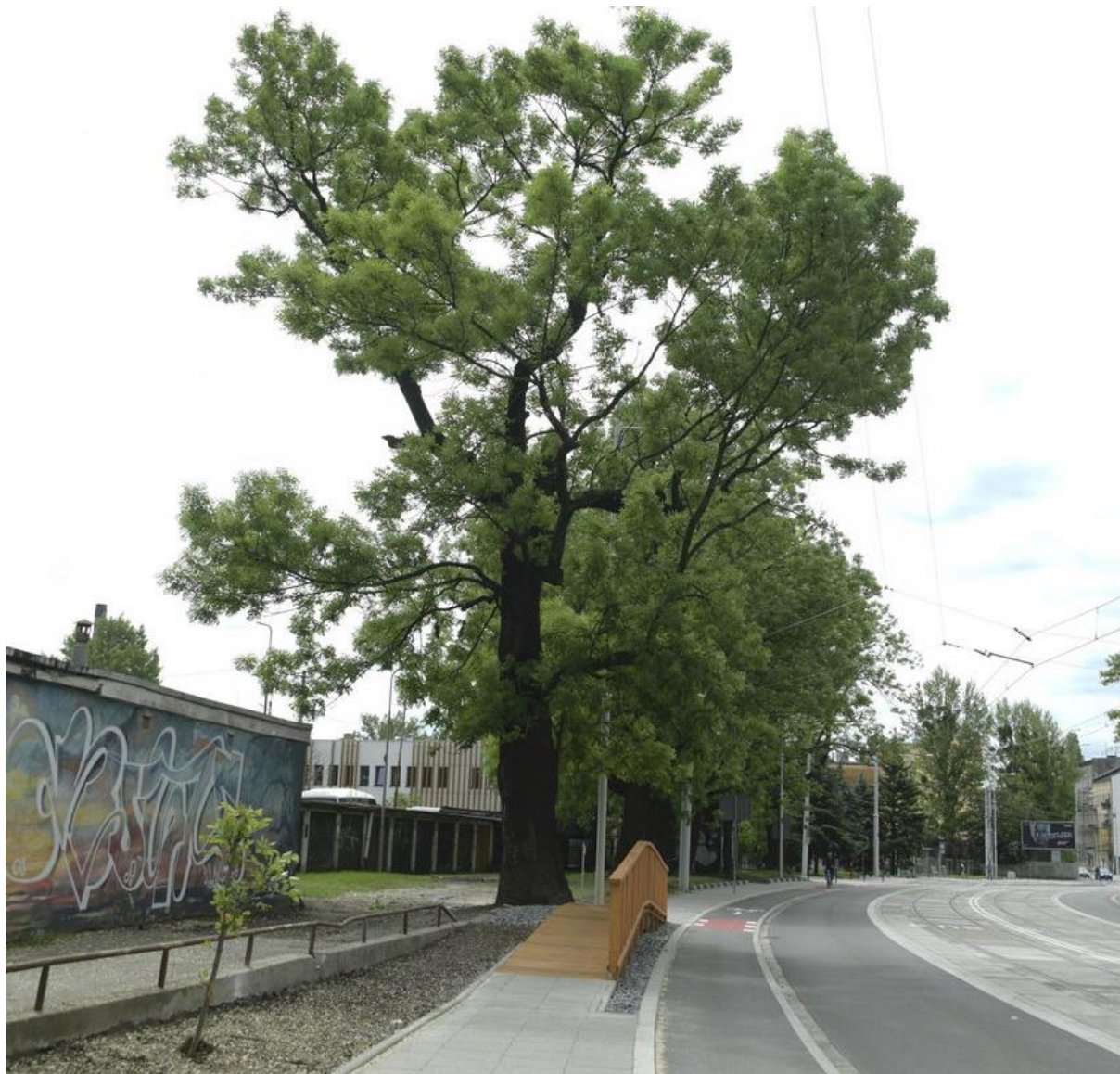
Ryc. 39 Kładka wyniesiona ponad system korzeniowy. Źródło: Zbudowali kładkę i uratowali drzewo (fakt.pl)
