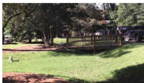
Ryc. 5 Trawiaste pasy buforowe w połączeniu z niecką chłonną (Aiken, Stany Zjednoczone) (Iwona Wagner, 2014)
