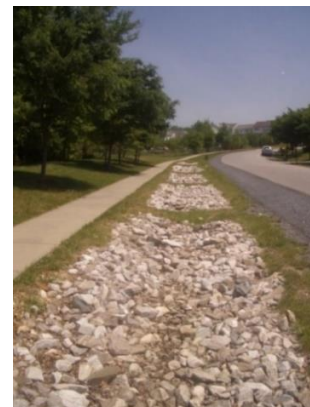
Ryc. 3 Drenaż francuski, źródła (od lewej): https://harborgreescapes.com/drainage/french-drain/ ; https://sustainablestormwater.org/2007/05/23/infiltration-trenches/
