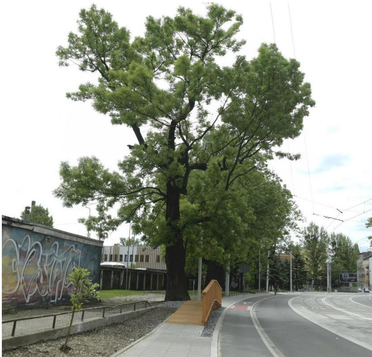
Ryc. 39 Kładka wyniesiona ponad system korzeniowy. Źródło: Zbudowali kładkę i uratowali drzewo (fakt.pl)
