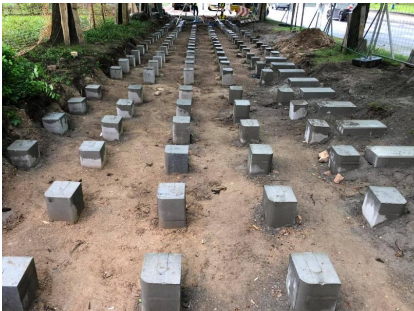
Ryc. 37 Betonowe posadowienie nawierzchni podwieszanej. Źródło: Podwieszana ścieżka rowerowa w Białymstoku ominię korzenie drzew. (whitemad.pl)
