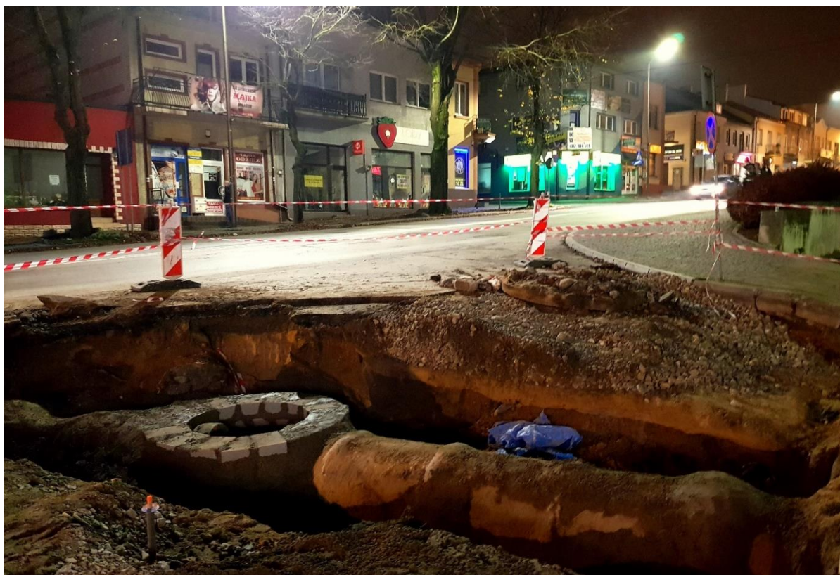
Przebudowa kanalizacji w okolicach Rynku
