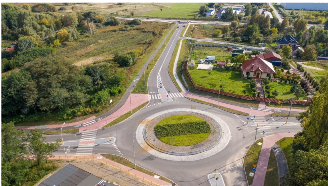
Droga gminna stanowiąca łącznik między nowopowstałym przedłużeniem ul. Furmańskiej i ul. Denkowskiej.
