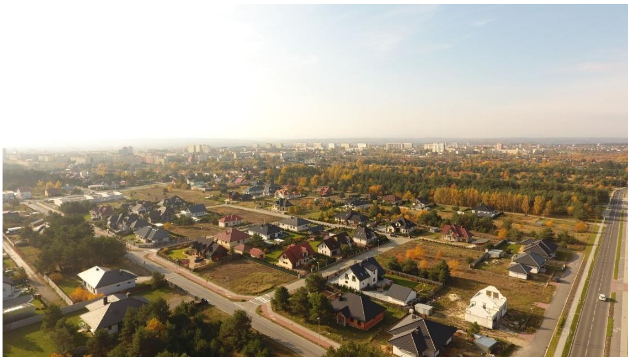
Kompleks domów przy ul. Krzemiennej.
