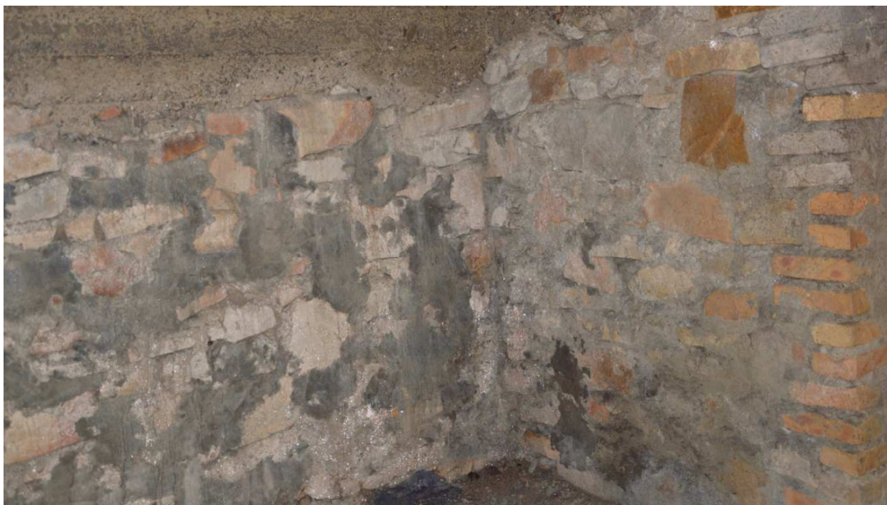
fot. stan techniczny ścian pomieszczenia – brak widocznych uszkodzeń, ślady napraw.
