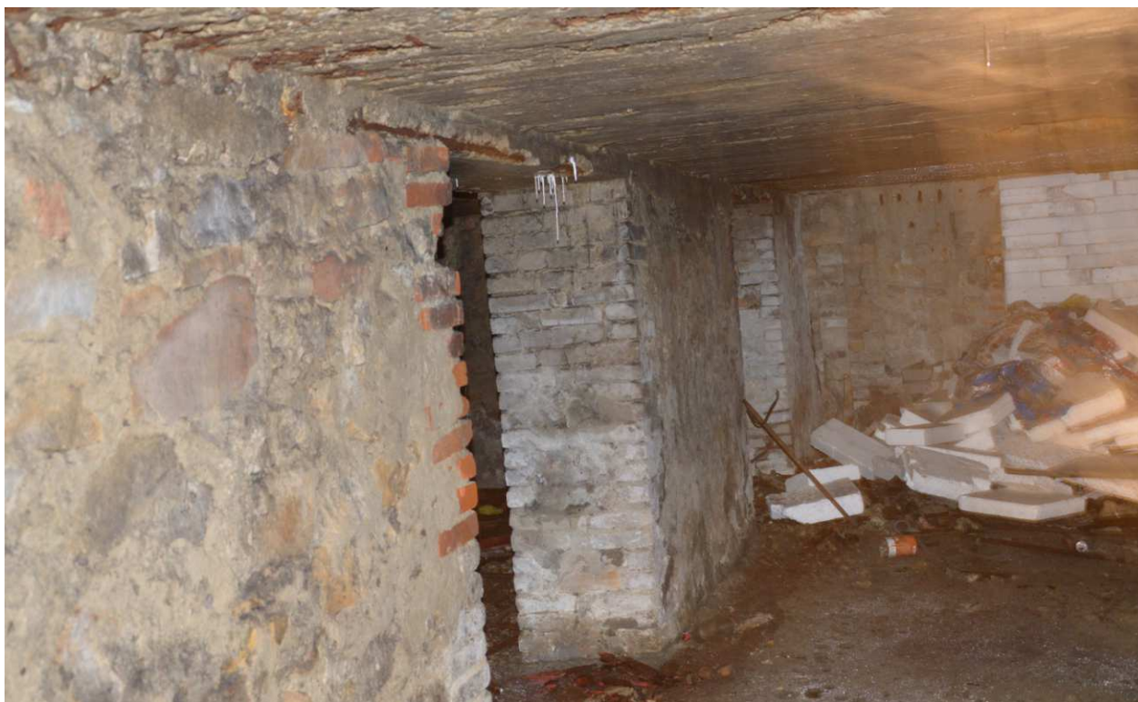
fot. Stan techniczny słupa - bez objawów zniszczenia.
