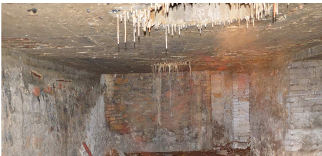
fot. efekt działania wody widoczny w obrębie włazów
