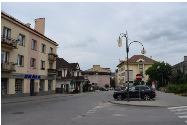
Fot. 15. Zabudowa mieszkaniowo-usługowa przy ul. Sienniejskiej
