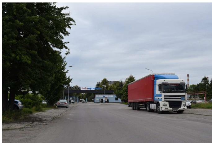
Fot. 39. Brama wjazdowa do Celsa Huty Ostrowiec
