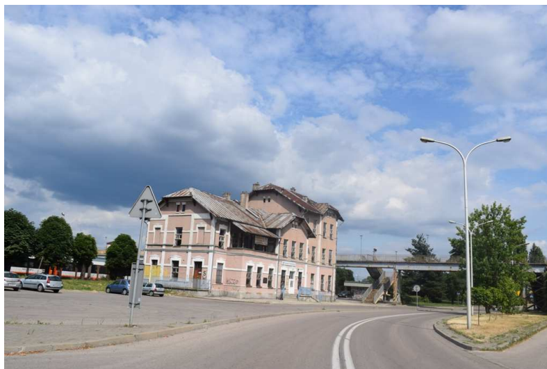
Fot. 24. Budynek dawnego dworca kolejowego przy ul. Kolejowej
