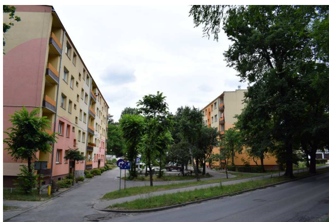
Fot. 10. Zabudowa mieszkaniowa wielorodzinną przy ul. Adama Mickiewicza
