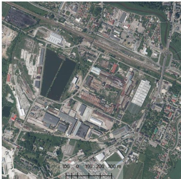
Fot.11. Teren byłych Zakładów Ostrowieckich (tzw. Stara Huta)
